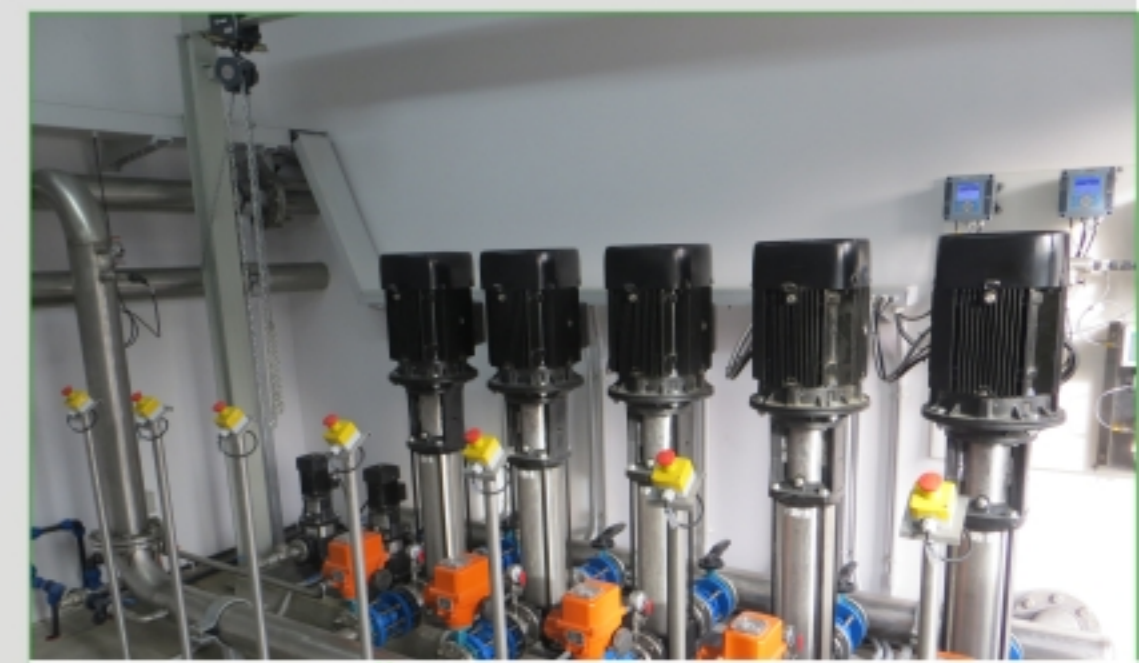
STAP Tășnad | Pompe noi instalate
