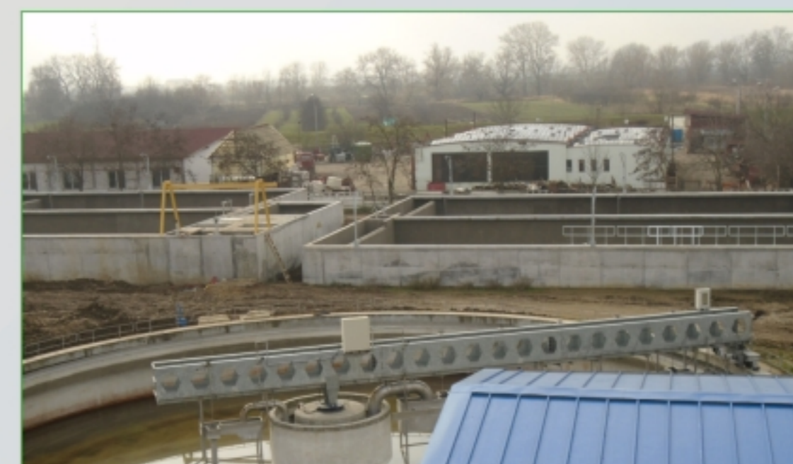
Treapta terțiară - bazine anaerobe, bazine anoxice
