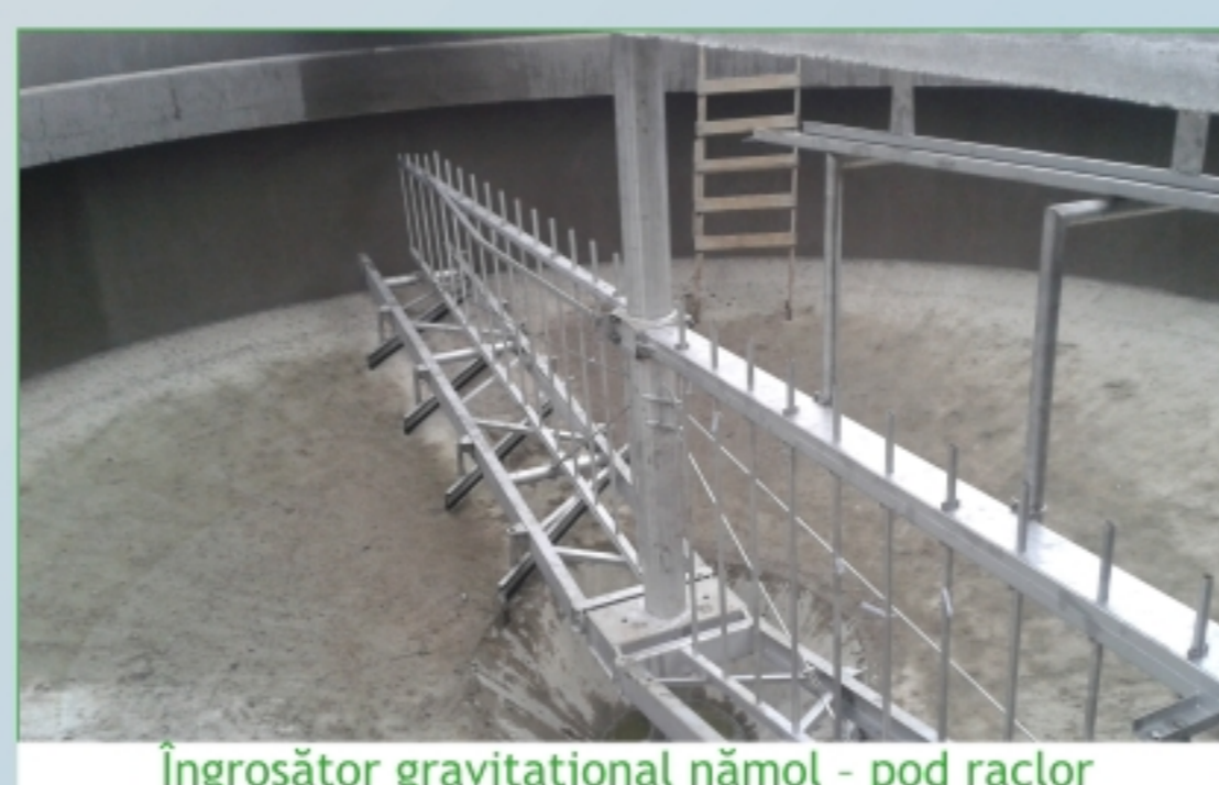
Îngroșător gravitațional nămol - pod raclor
