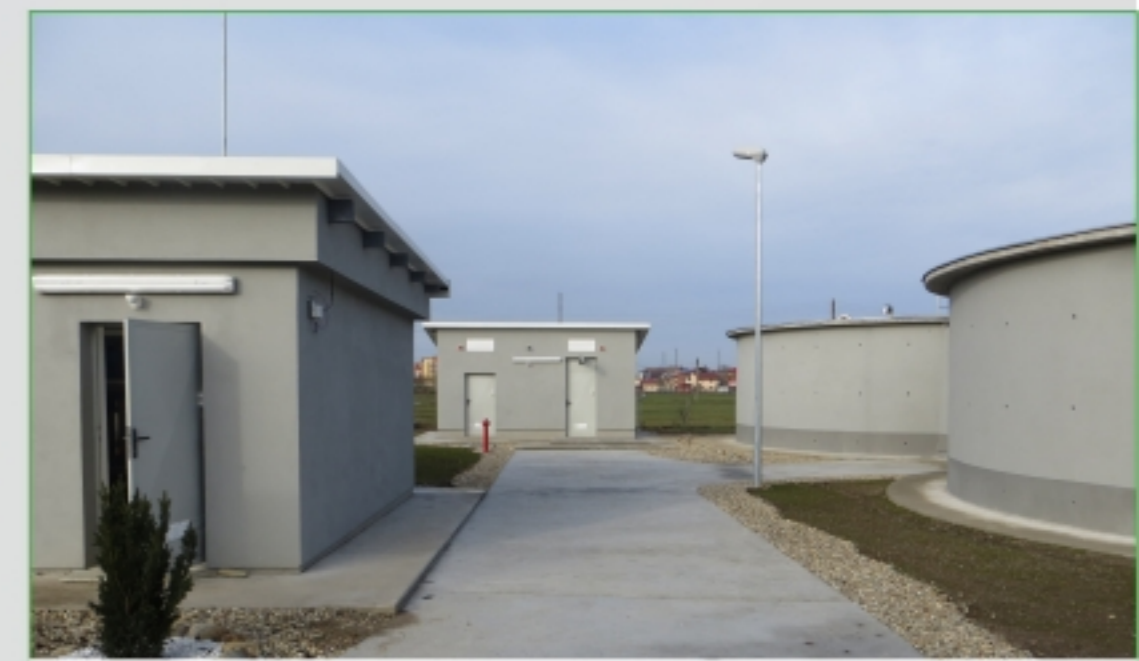
STAP Tășnad | Stația de pompare
