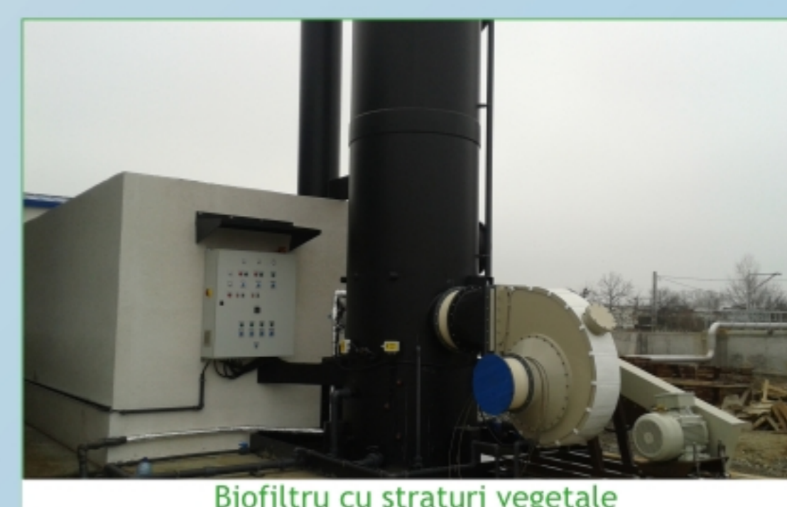
Biofiltru cu straturi vegetale
