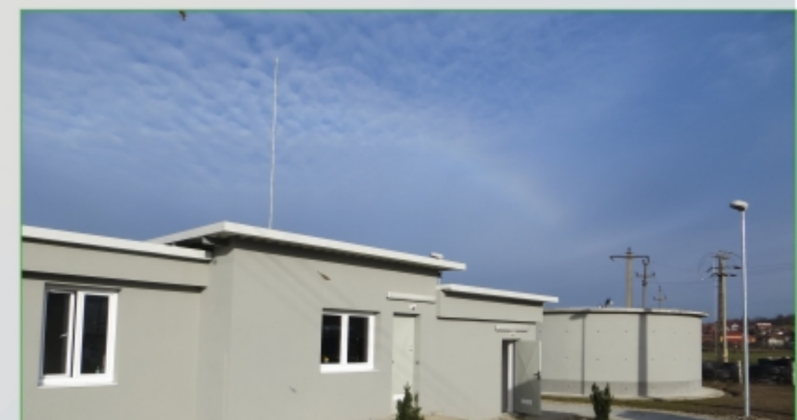
STAP Tășnad | Stația de pompare, stația de clorinare și rezervoare de apă
