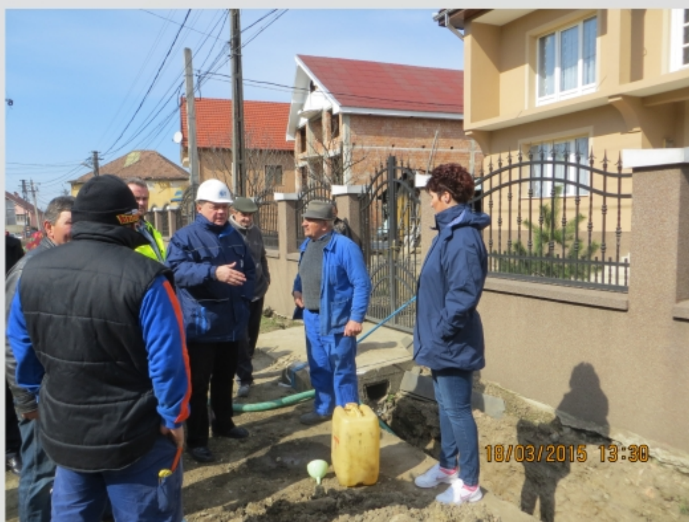
Vizită la lucrările de reabilitare a conductei de aducțiune pe tronsonul Valea Rea - Huta Certeze
