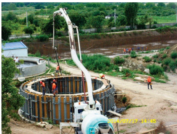
Fig. 2. Stația de epurare a apelor uzate Satu Mare: lucrări de construcții - îngroșător gravitațional (SM-CL-01).
