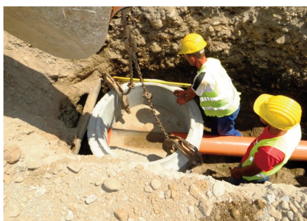
Fig. 8. Lucrări de construcții rețele de canalizare în orașul Negrești Oaș (SM-CL-13).
