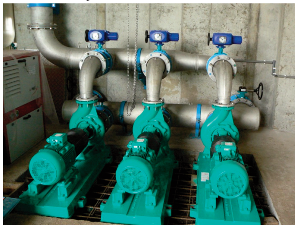
Fig. 3. Stația de tratare a apei potabile Doba: pompe noi instalate – alimentare filtre închise (SM-CL-02).
