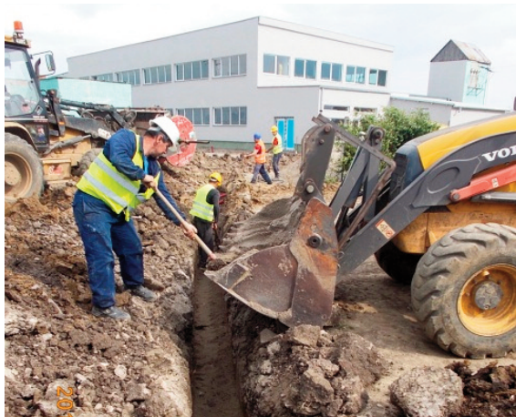
Fig.4. Stația de tratare a apei potabile Doba: pozare cabluri electrice – alimentare front de captare (SM-CL-02).
