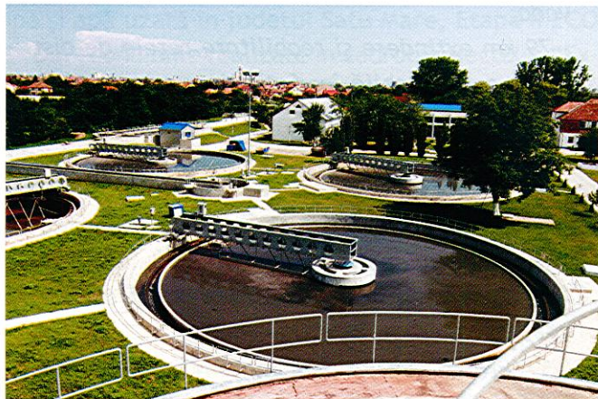
Fig. 4. Stația de epurare Satu Mare reabilitată.
