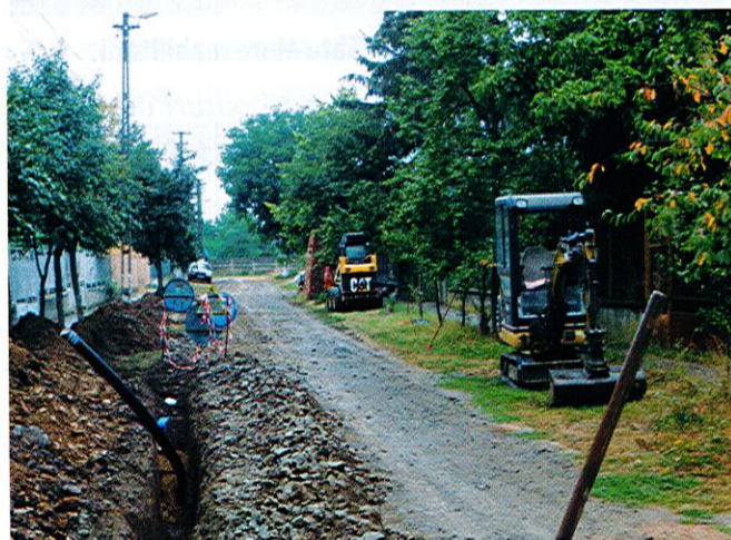
Fig. 7. Extinderea și reabilitarea rețelelor de apă în județul Satu Mare.
