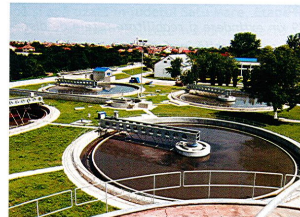
Fig. 4. Stația de epurare Satu Mare reabilitată.
