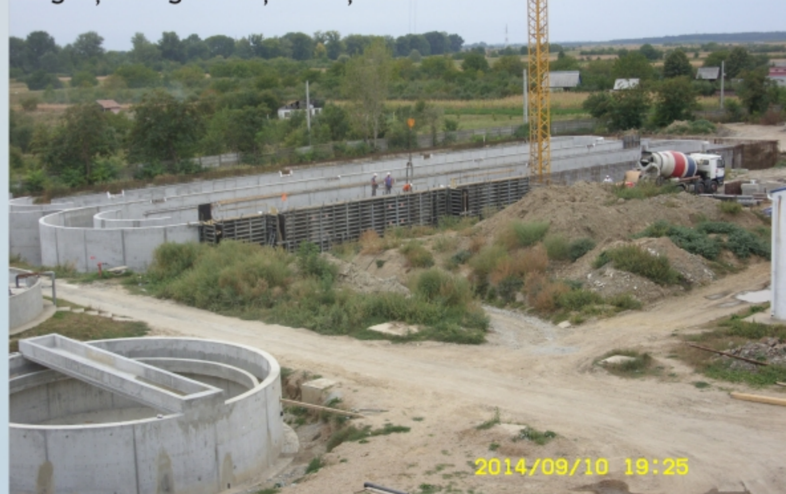
Îngroșător gravitațional și bazin Carousel
